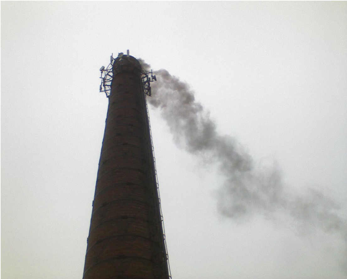
Экспериментальная Установка отключена. Октябрь 2009 г.
