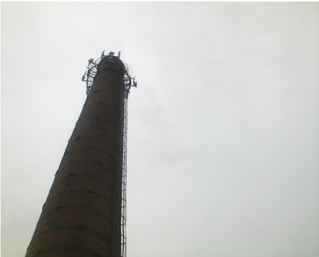
Экспериментальная Установка включена. Та же труба через 5 минут.
